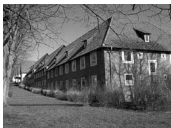
Der „Burghof“ – eine Sanierung ist nicht in Aussicht
